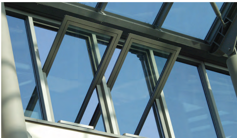
Приводы D+N обеспечивают быстрое и надежное открывание окон для дымоудаления.
